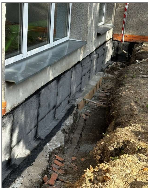
Foto – nová izolace budovy proti vodě, nové podlahy ve společných prostorách, práce v družině ZŠ
